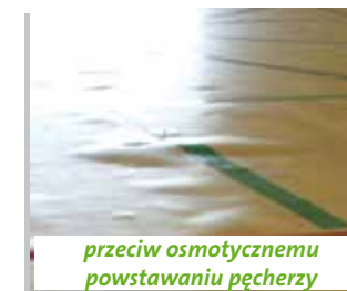
posadzki bez izolacji poziomej
