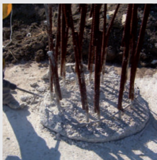
Skucie nadmiaru betonu i oczyszczenie powierzchni uszczelnienia
