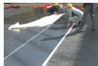
Uszczelnienie wykonane membraną KÖSTER KSK
