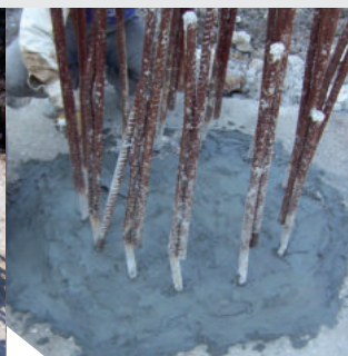
Wykonanie fasety/wyoblenia i wyrównanie powierzchni szybkością zaprawą KÖSTER Sperrmörtel
