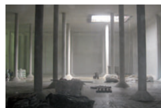
Hydroizolacja zbiornika od strony pozytywnej z wykorzystaniem mikrozaprawy KÖSTER NB1 szary
