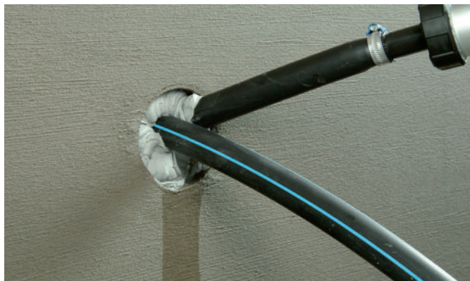
Pastę KÖSTER KB-Flex 200 wyciska się w przestrzeń do wypełnienia pistoletem ręcznym
