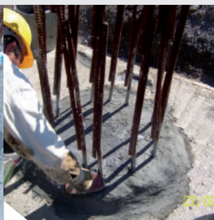
Uszczelnienie powierzchni głowicy pala mikrokryształicznym szlamem mineralnym KÖSTER NB 1 szary.
