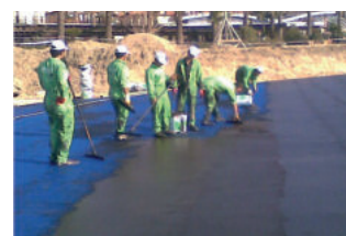
Uszczelnienie wykonane masą bitumiczno-polimerową typu PMBC KÖSTER Deuxan 2K
