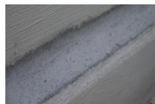
Faseta wykonana z zaprawy KÖSTER Sperrmörtel WU
