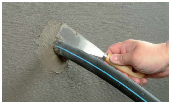
Dla ochrony uszczelnienia powierzchniowo zamyka się go szybkością zaprawą KÖSTER KB-Fix 5
