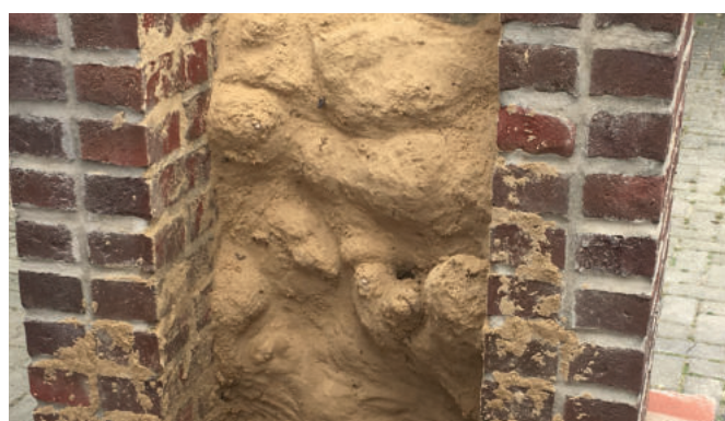
Iniekcja kurtynowa, widok od strony uszczelnienia
