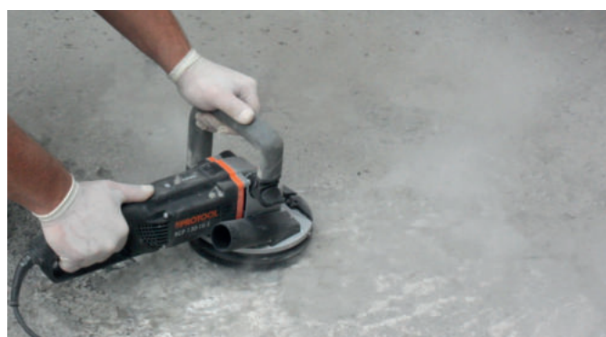
Przygotowanie podłoża
