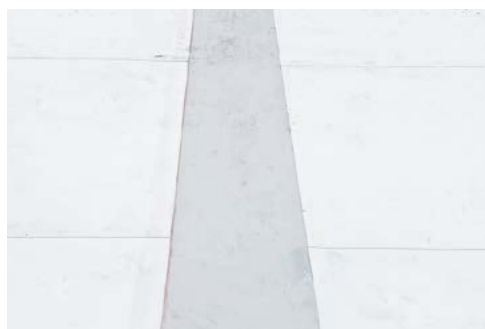
Pasek TPO nakładany na większą odległość
