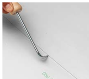
Kontrola zgrzewu za pomocą testera połączeń
