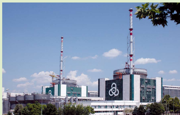
Elektrownia atomowa, Kozłoduj, Bułgaria
