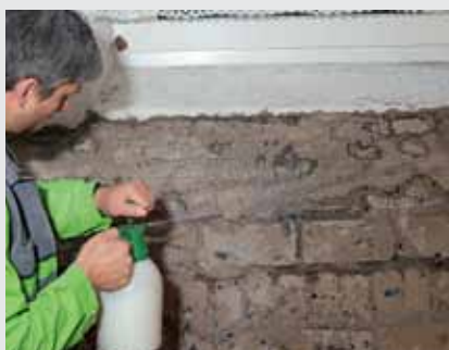
KÖSTER Polysil TG 500, gruntowanie
