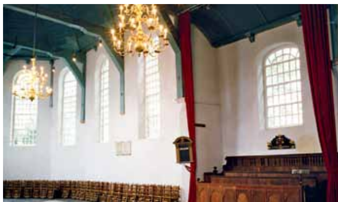
Mury tego zabytkowego obiektu zostały naprawione tynkami renowacyjnymi KÖSTER Sanierputz
