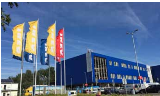
Pokrycie dachu membraną KÖSTER TPO, IKEA, Delft, Niderlandy
