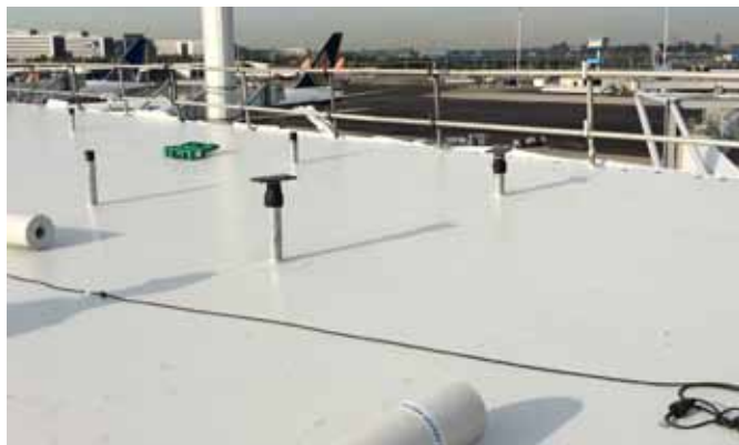
Pokrycie dachu membraną KÖSTER TPO, terminal lotniska Schiphol, Amsterdam, Niderlandy
