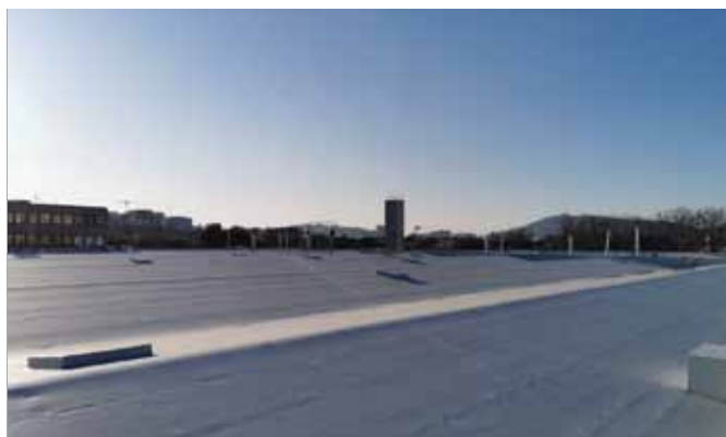
Pokrycie dachu membraną KÖSTER TPO, zakłady produkcyjne Food Court, Costa Del Este, Panama
