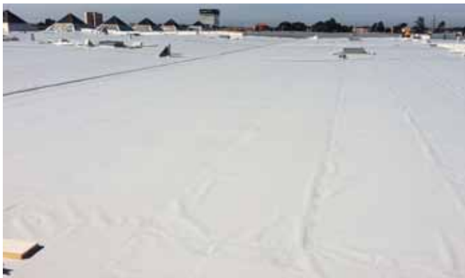
Pokrycie dachu membraną KÖSTER TPO, supermarket Pingo Doce, Aveiro, Portugalia
