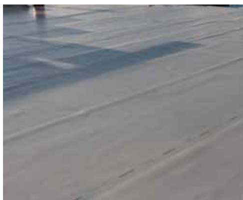
Ułożenie luźne pod balast
