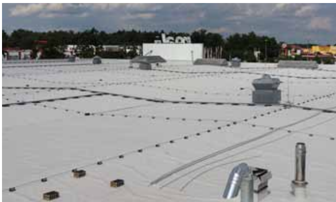
Pokrycie dachu membraną KÖSTER TPO, hipermarket REAL w Gifhorn, Niemcy
