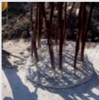
Skucie nadmiaru betonu i oczyszczenie powierzchni uszczelnienia
