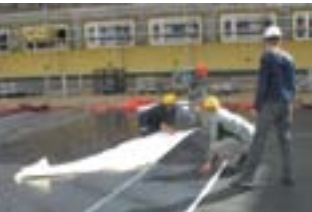
Uszczelnienie wykonane membraną KÖSTER KSK
