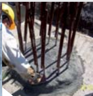
Uszczelnienie powierzchni głowicy pała mikrokrystalicznym szlamem mineralnym KÖSTER NB 1 szary.
