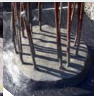
Uszczelnienie styku głowicy pała z uszczelnieniem powierzchni masą bitumiczno-polimerową typu PMBC KÖSTER Deuxan 2K
