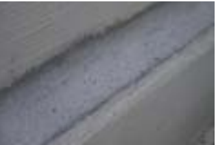
Faseta wykonana z zaprawy KÖSTER Sperrmörtel WU
