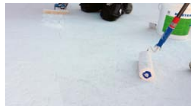
Nakładanie drugiej warstwy KÖSTER 21
