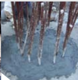
Wykonanie fasety/wyoblenia i wyrównanie powierzchni szybkością zaprawą KÖSTER Sperrmörtel
