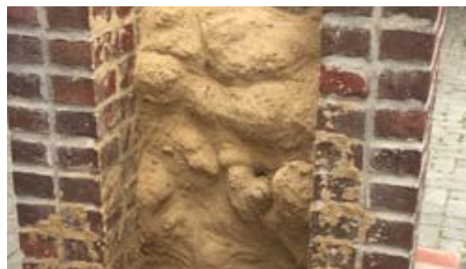
Iniekcja kurtynowa, widok od strony uszczelnienia
