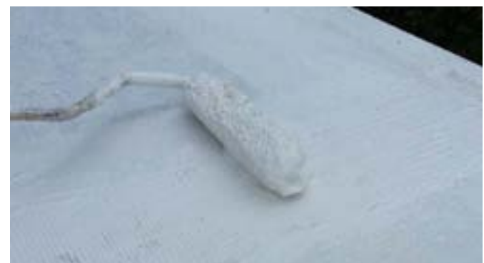
Pierwsza warstwa KÖSTER 21 z zatopieniem włókniny KÖSTER Flexgewebe
