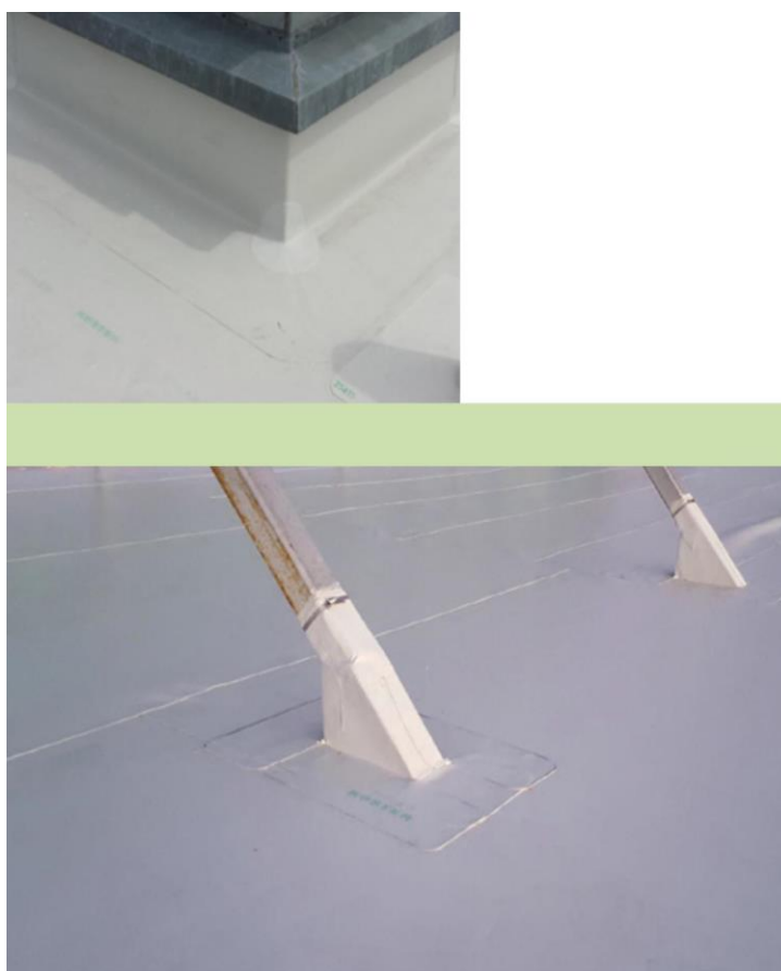
Uszczelnienie prostokątnych elementów na dachu
