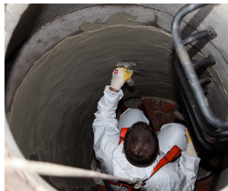
Zaprawa jest nakładana na zwilżone podłoża za pomocą pacy metalowej
