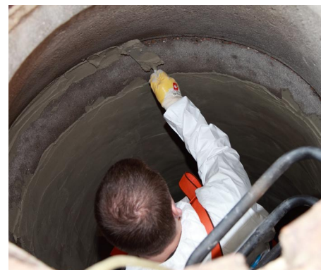
Uszczelnienie na łączeniu kręgów studzienek
