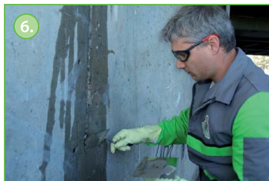
Zamknięcie powierzchni czołowej rysy zaprawą szybkowiązącą KÖSTER KB-Fix 5. Zamknięcie pęknięcia zapobiega niekontrolowanemu wypływowi materiału iniekcyjnego poprzez rysę podczas iniekcji. Czas wiązania zaprawy wynosi ok. 5 minut, zależy od temperatury otoczenia i wilgotności.
