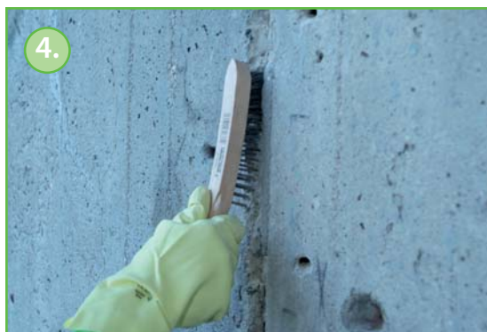
4. Oczyszczenie rysy za pomocą szczotki drucianej.
