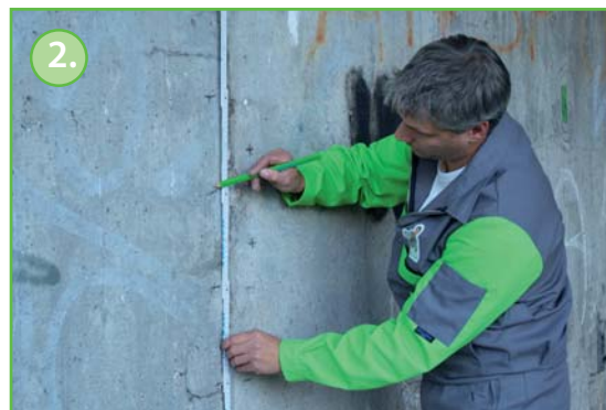
2. Oznaczenie miejsc, gdzie mają być wykonane odwierty. Otwory umieszczone są naprzemiennie wzdłuż pęknięcia, w odstępach od 10 do 15 cm.
