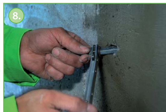
Dokręcanie pakerów.
