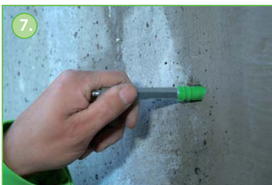
Instalacja pakerów KÖSTER Superpaker w otworach wiertniczych, należy pozostawić co trzeci odwiert otwarty.
