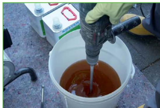
Do mieszania żywicy KÖSTER KB-Pur 2 IN 1 stosuje się mieszadło wolnoobrotowe. Składniki powinny być mieszane do uzyskania homogenicznej mieszaniny.
