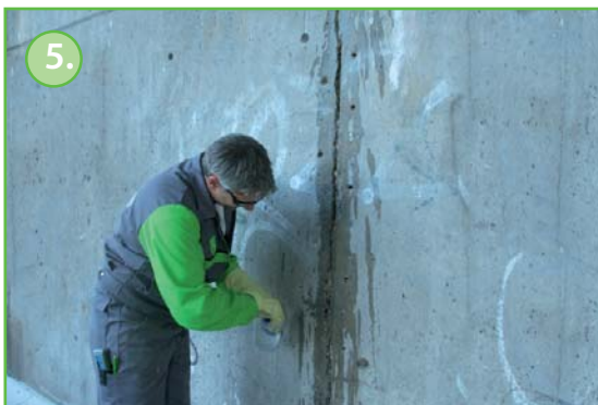
Nawilżenie obszaru pęknięcia.
