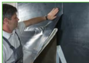
Klejenie membrany KSK
