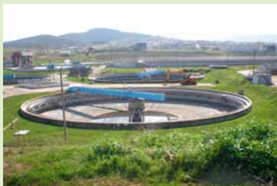
Pročistač otpadnih voda, Istanbul, Turska
